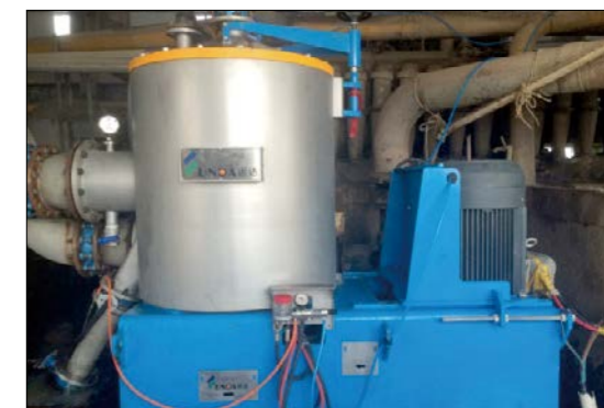
图 2. 现场安装运行的超级筛 SSC40
