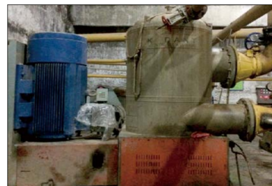
图 1. 现场安装运行的原一段粗筛
